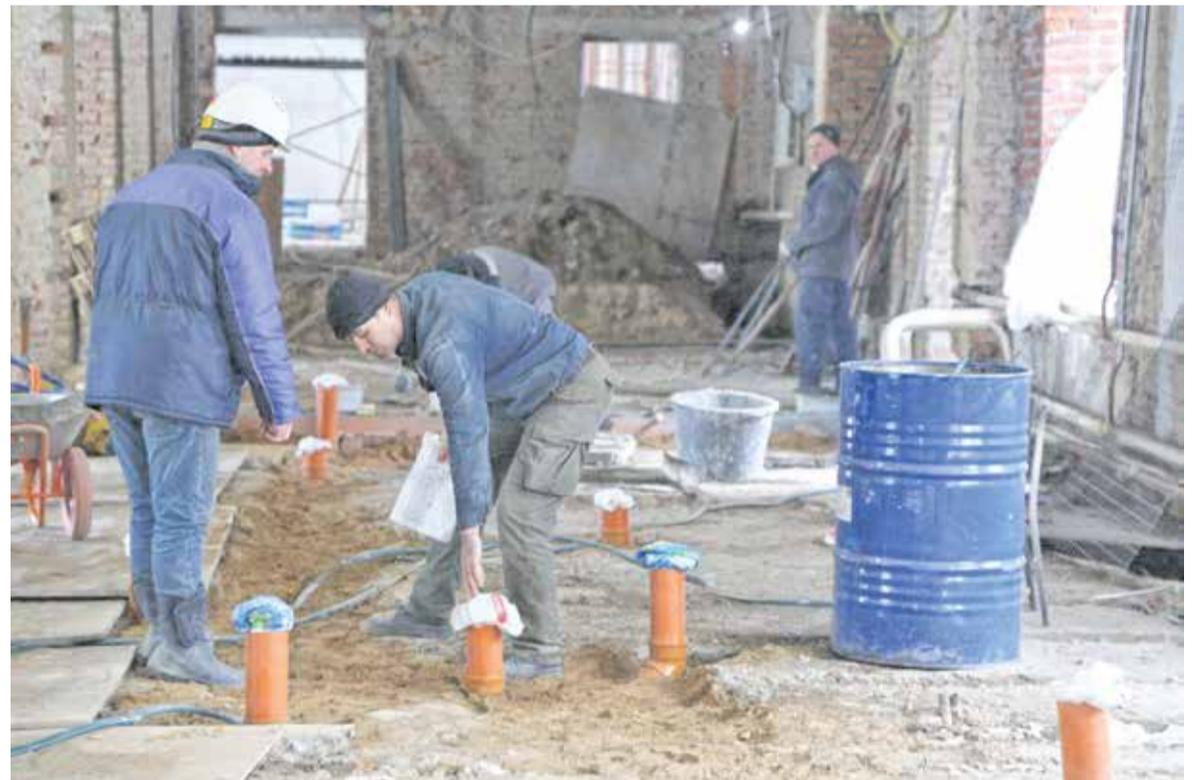
В настоящее время в каждом из зданий завершается демонтаж. В Туровской школе местечка Данки начаты работы по усилению фундамента, частичному восстановлению перекрытия над актовым залом. Проводится монтаж перегородок для основания пола на первом этаже. Обеспечивают усиление стропильных систем, монтаж кабельных линий электроснабжения, систем водоотведения и водоснабжения, устройство торцевой стены актового зала.
