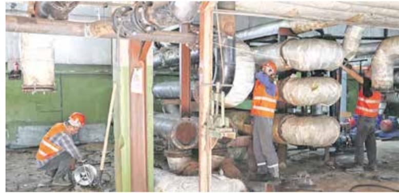
му жилищному надзору региона вместе с советами домов проводят обходы. Инспекторы проверяют исправность электрооборудования, опрессовку систем отопления, теплоизоляцию на трубопроводах ГВС, насколько сухие подвалы.
